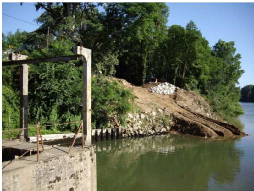
Figure 12 : Rampe d'accès utilisée en 2008
