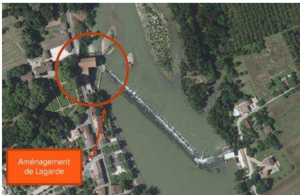
Figure 2 : Vue d'ensemble aérienne de l'aménagement
