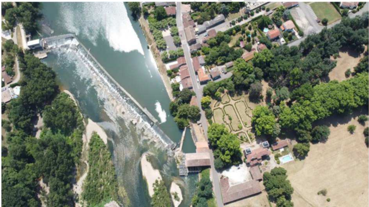
Usine de Lagarde (82)
