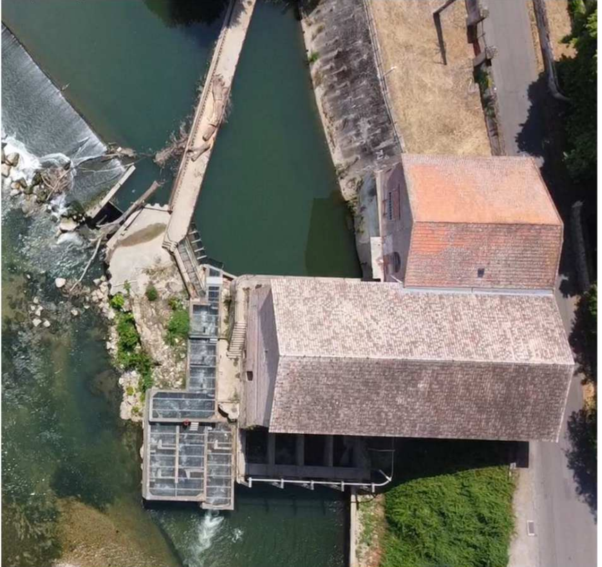
Figure 3: Vue de la passe à poissons
